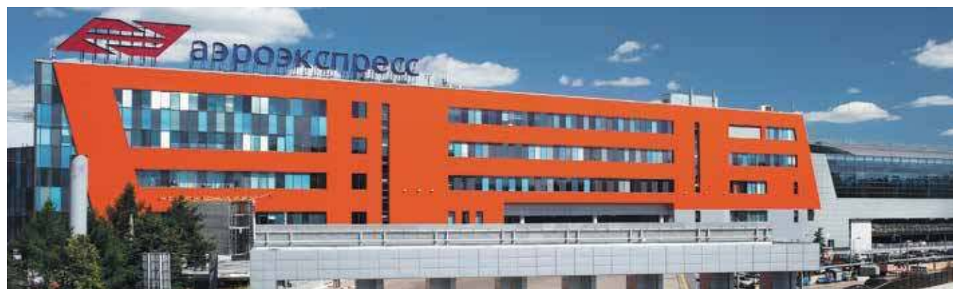
ООО «АЭРОЭКСПРЕСС», г. Химки
