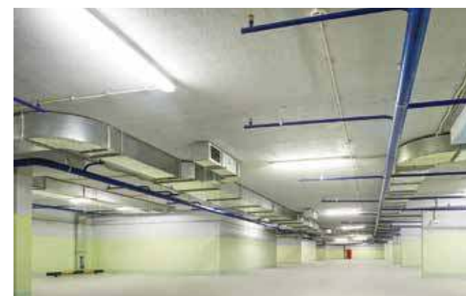
Подземная двухуровневая автостоянка, г. Королев
